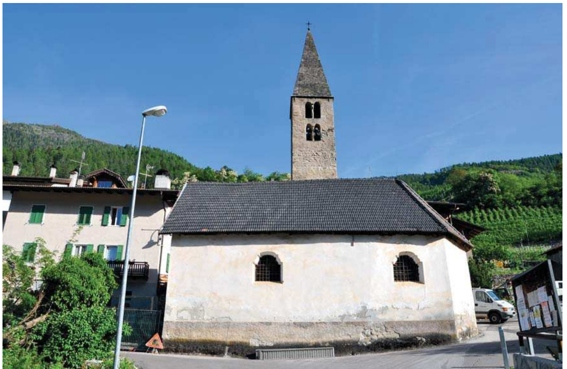
Fig. 1. Caldes, chiesa di San Tommaso a Cassana.
