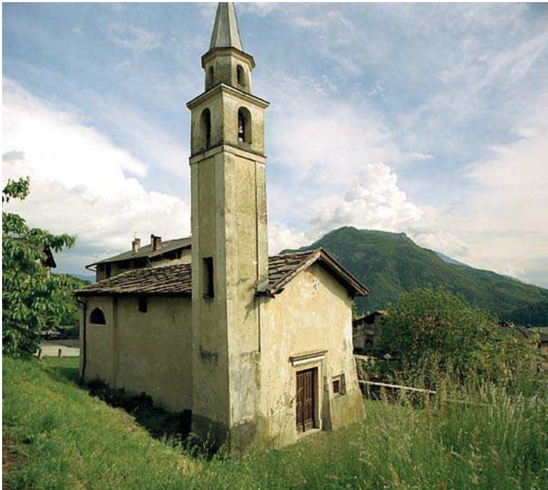
Fig. 4. Civezzano, loc. Garzano, chiesa di San Valentino.
